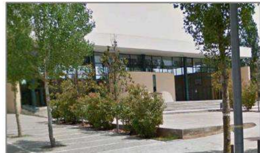
Façana sud del pavelló
