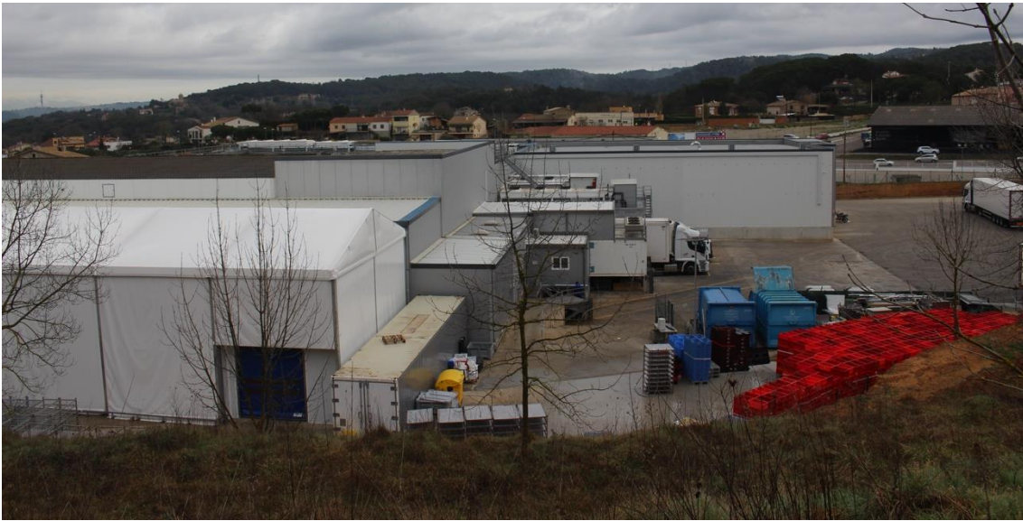
Imatge 10. Façana nord.
